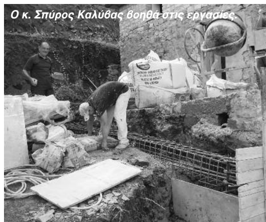
Έγινε αντιστήριξη της νότιας πλευράς του Ξενώνα στο χώρο της κουζίνας και της τουαλέτας.
